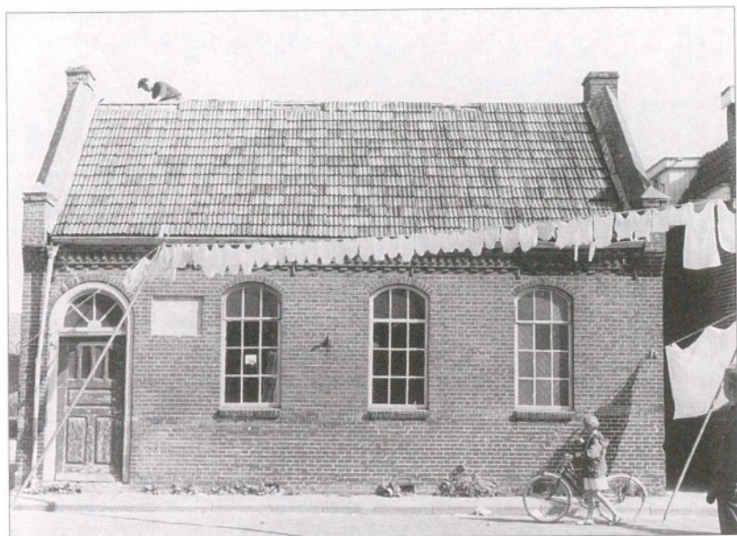
Het gereformeerde verenigingsgebouwtje Samuël. Het stond aan de Prins Hendrikstraat, op de plek waar nu modecentrum G. Oost is. De sloop van het gebouw is net begonnen (foto Albert van Urk).
