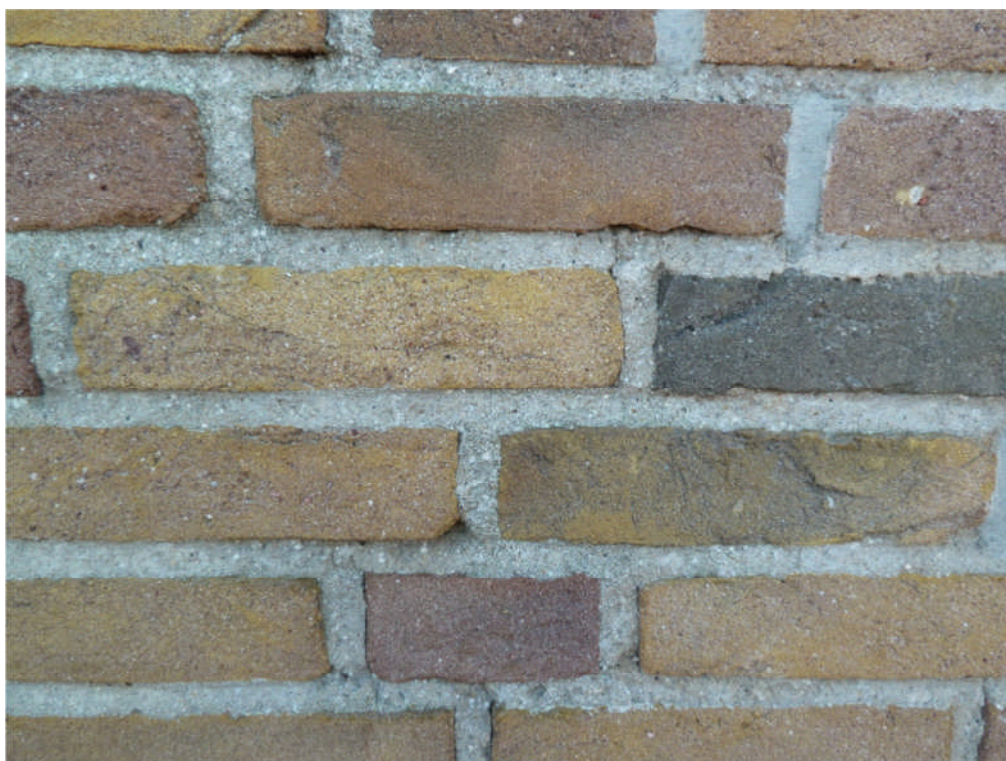
Foto 4.96: Noordgevel (boven de klok): hier ziet het voegwerk er wat slechter uit (meer oneffen).
