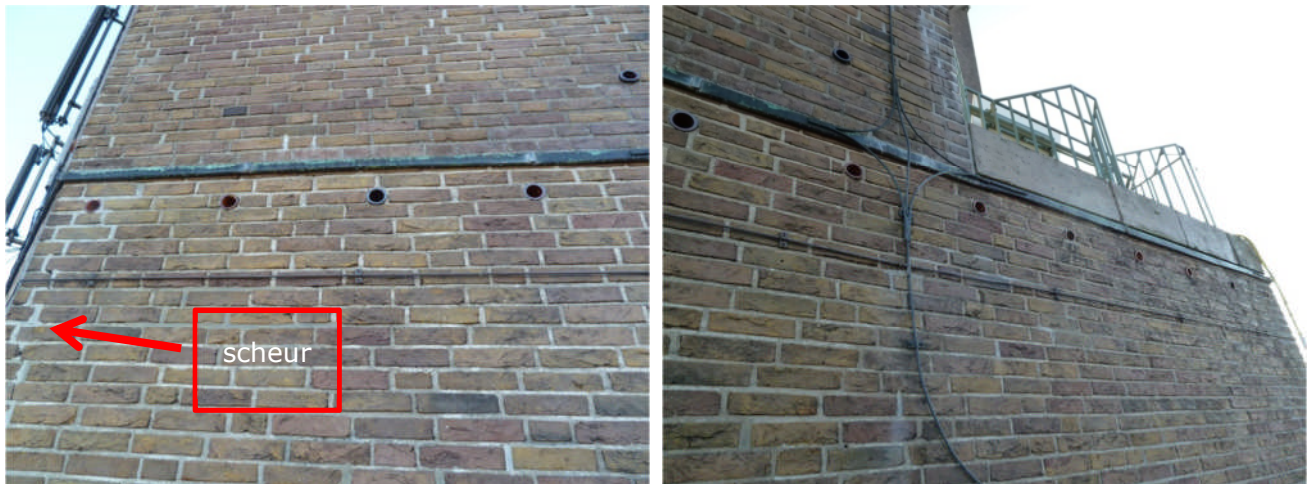
Foto 4.106a en -b: Noordwestgevel (ter hoogte van het platform): net onder de rand van het platform en ook daarboven zijn drainagebuizen in de gevel opgenomen.
