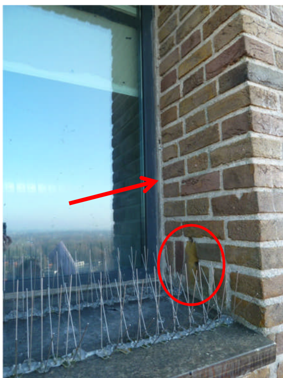
Foto 4.111a en -b: Noordwestgevel: hier ontbreekt de 'extra' voegdichting rondom de kozijnen. Door aanwezigheid van de duivenwering wordt de waterafvoer over de vensterbank belemmerd. Ook zijn er beschadigingen aan het metselwerk aanwezig (foto 1).
