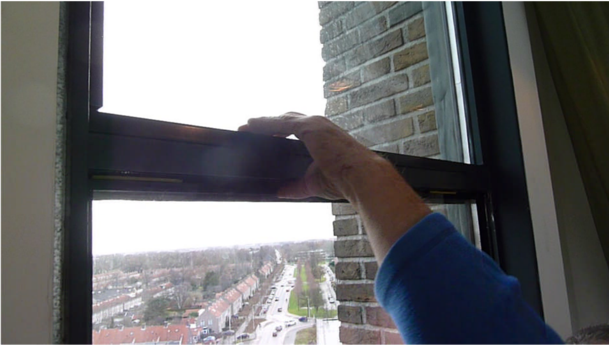
Foto 4.44: 7 e verd. – het tussenkalf in het aluminium raam zit los.
