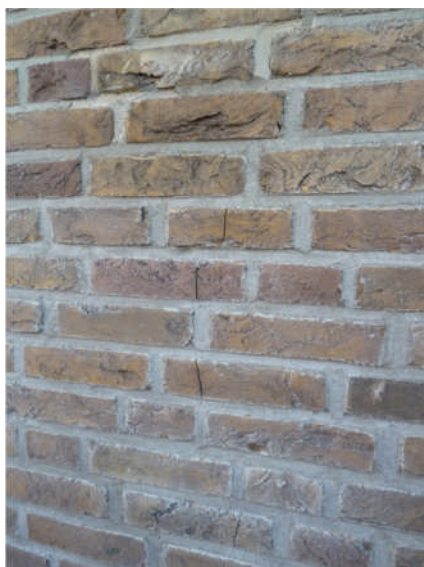
Foto 4.128a en -b: Zuidoostgevel (ter hoogte van 11 e verd.): Scheur in metselwerk.
