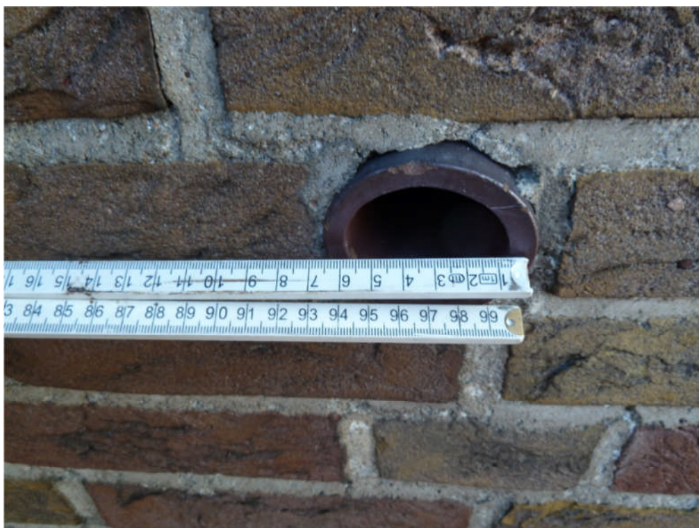
Foto 4.109: Noordwestgevel (ter hoogte van het platform): breedte van de buizen is circa 50 mm (inwendig).
