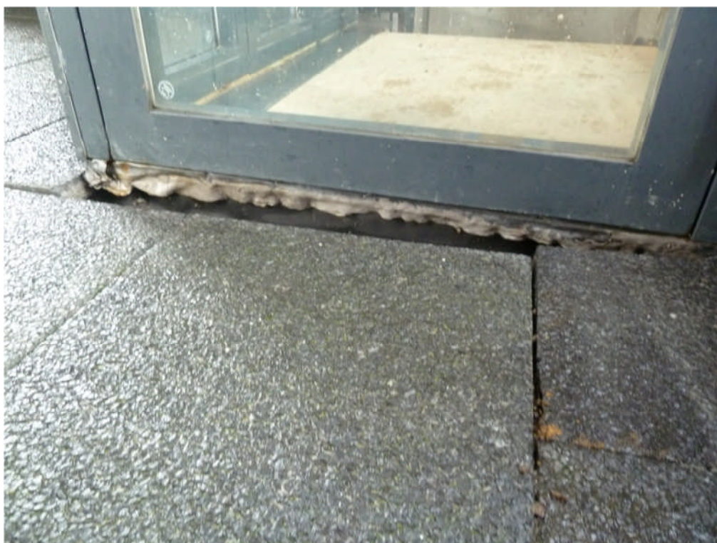
Foto 4.158: Visuele opname dak platform – lood is van slechte kwaliteit.
