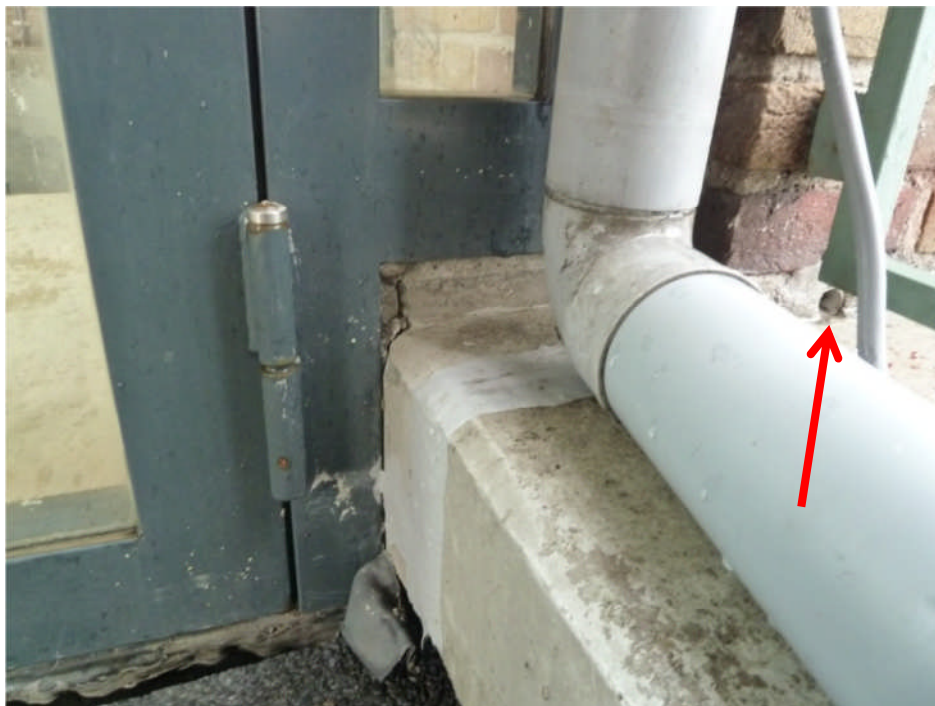
Foto 4.147: Sproeitest platform –open verbinding van binnen naar buiten. Zie ook de voorgaande foto.
