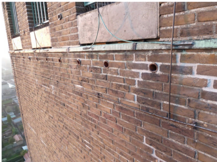
Foto 4.129: Zuidgevel: overzichtsfoto drainagebuizen t.p.v. platform. Ook is hier hersteld voegwerk te zien.
