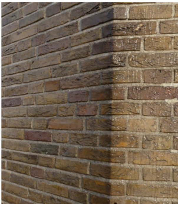
Foto 4.69a- en -b: Het condensaat (gehele gevel is nat), als gevolg van nachtelijke onderkoeling, is als een 'film van waterparels' op de gevel zichtbaar.
