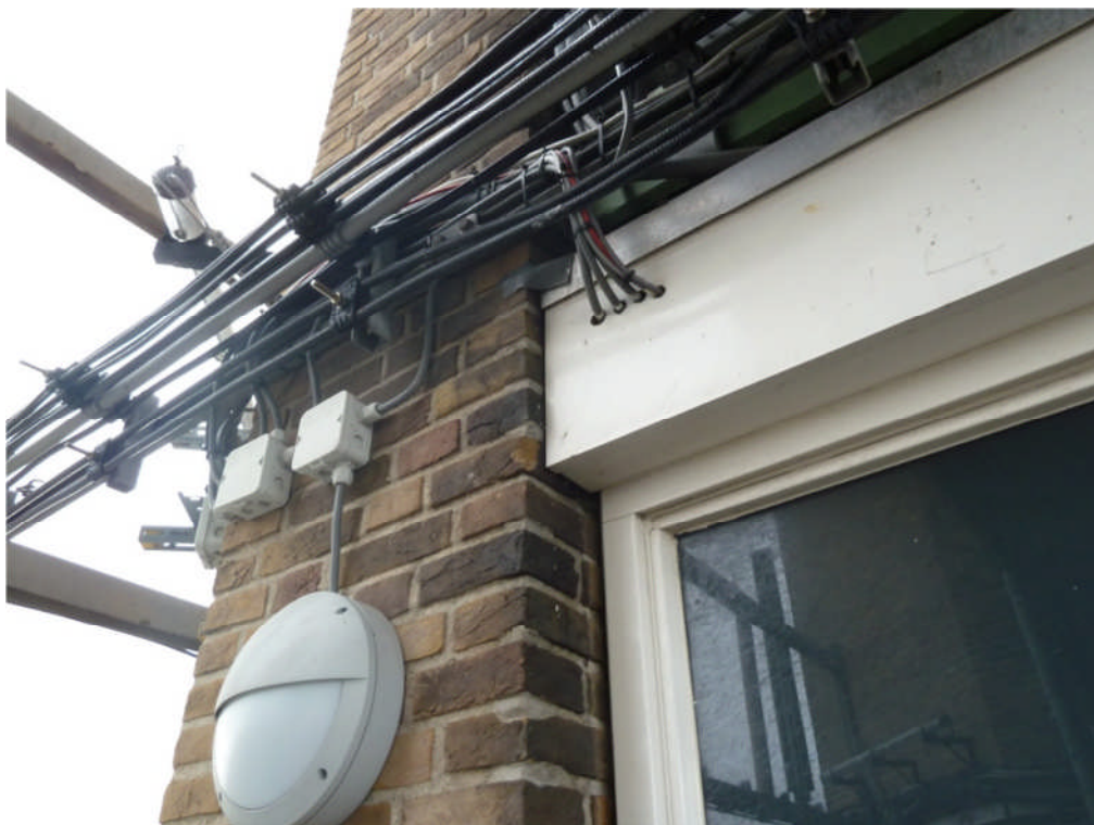
Foto 4.152: Visuele opname dak platform.
