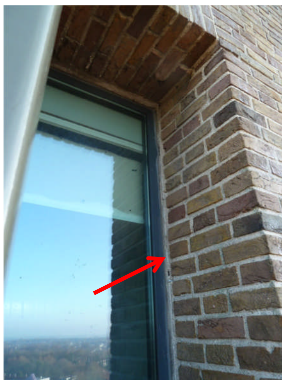
Foto 4.111a en -b: Noordwestgevel: hier ontbreekt de 'extra' voegdichting rondom de kozijnen. Door aanwezigheid van de duivenwering wordt de waterafvoer over de vensterbank belemmerd. Ook zijn er beschadigingen aan het metselwerk aanwezig (foto 1).
