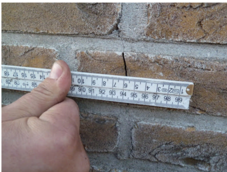
Foto 4.128a en -b: Zuidoostgevel (ter hoogte van 11 e verd.): Scheur in metselwerk.
