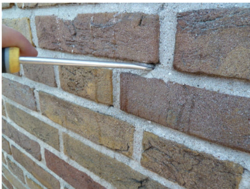
Foto 4.83: Noordgevel: op een enkele plaats is het voegwerk slecht.
