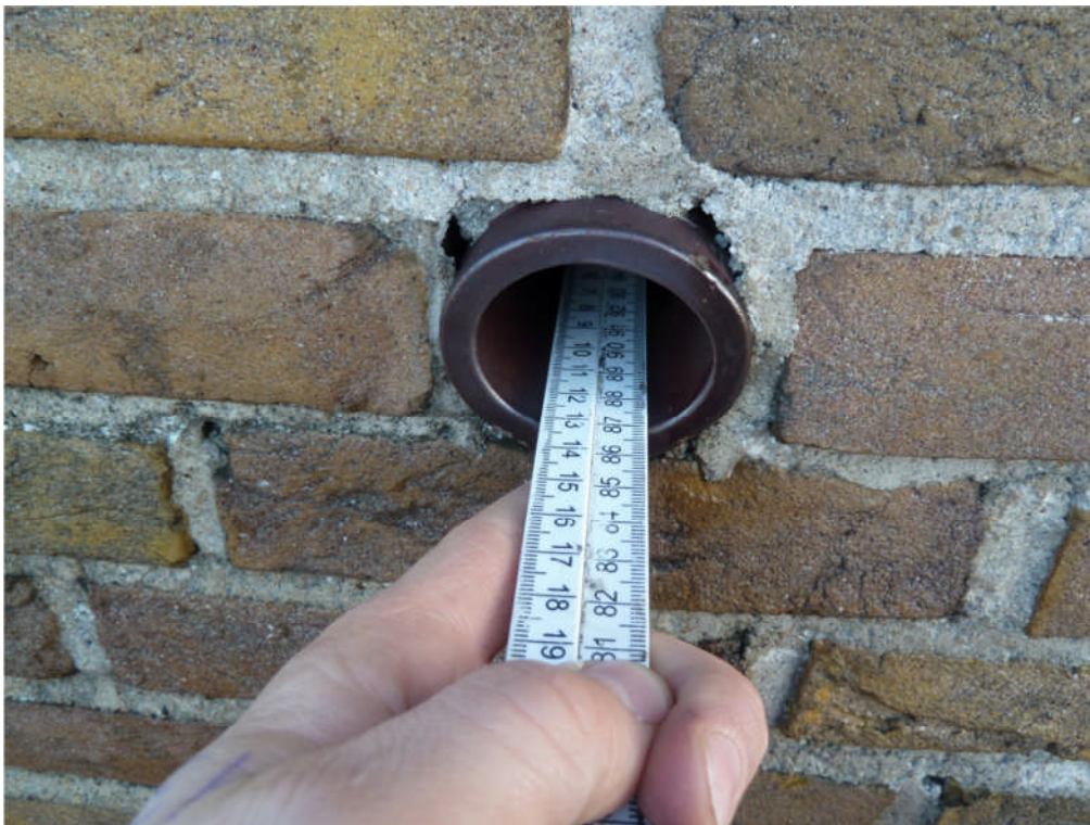
Foto 4.107: Noordwestgevel (ter hoogte van het platform): diepte drainagebuis is circa 13 cm.
