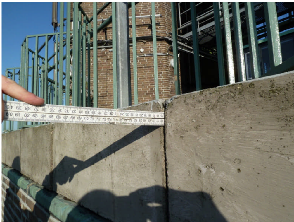
Foto 4.122: Westgevel: duimstok kan tot circa 15 cm tussen de elementen worden gestoken.
