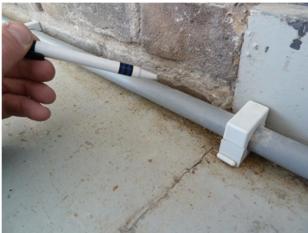
Foto 4.66: Sproeitest 12 e verdieping lifthal – vochtdoorslag gevel (t.p.v. rechter raam).
