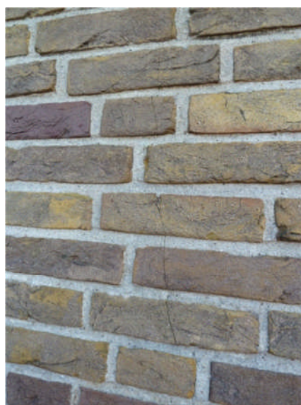
Foto 4.116a en -b: Noordwestgevel (tussen 6 e en 7 e verdieping): haarscheur (0,1 mm).
