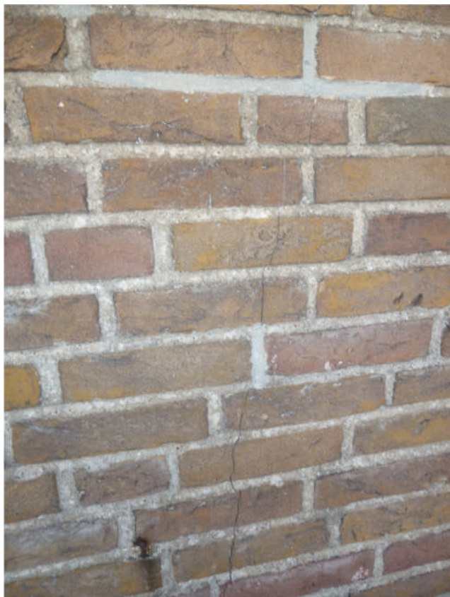
Foto 4.133: Zuidwestgevel: haarscheur t.p.v. 7 e verd. vloer. Loopt naar onder door tot 3 e verd. (verloopt naar circa 1-2 mm).
