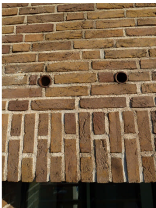
Foto 4.119: Westgevel: drainageopeningen boven het raam (deze buizen komen uit de spouw van boven).
