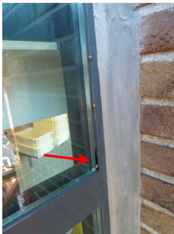
Foto 4.112a en -b: Noordwestgevel – grote openingen (circa 3 mm) in kozijnverbindingen. Raamrubbers zijn te kort (foto 2) – uit de glassponning komt ongedierte.
