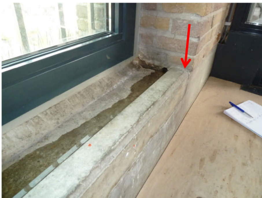
Foto 4.146: Sproeitest platform – ook hier is een open verbinding van binnen naar buiten aanwezig. Zie ook de volgende foto.
