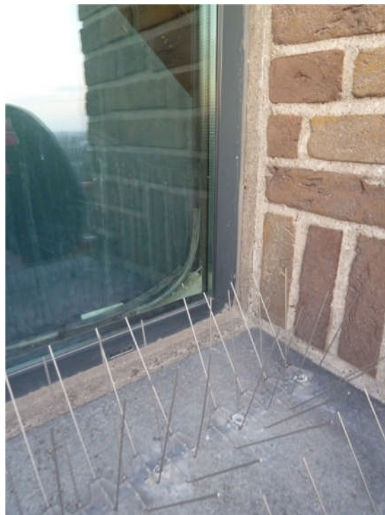
Foto 4.137a en -b: Zuidwestgevel: kitvoeg te dicht bij ontwateringssleuf / ontbrekend afdekdopje kozijn / geen kitband rondom kozijnaansluiting.
