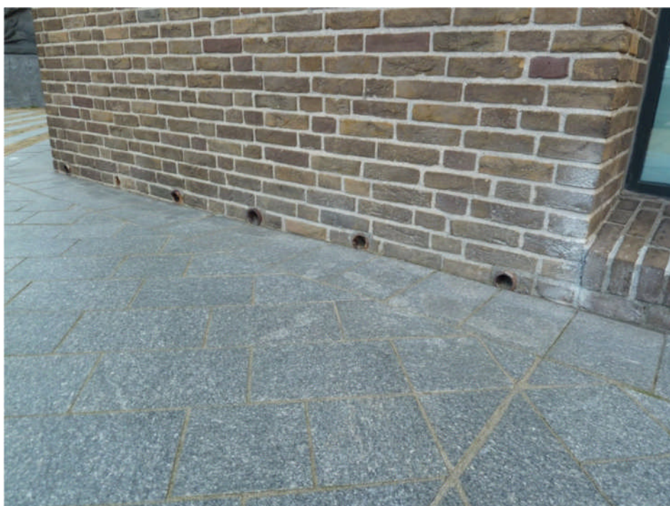
Foto 4.79: Onder in de gevel zijn drainagebuizen zichtbaar. Ook op hoger gelegen geveldelen komen deze voor.
