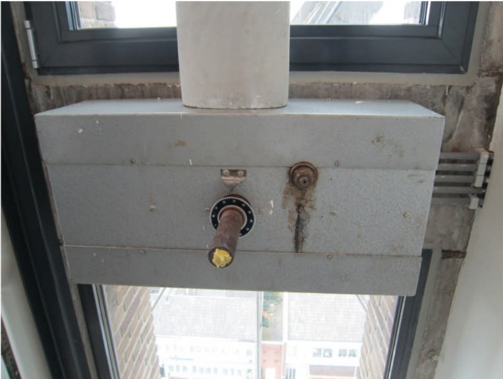
Foto 4.5: Leksporen ter plaatse van de betonnen kaders achter het uurwerk.
