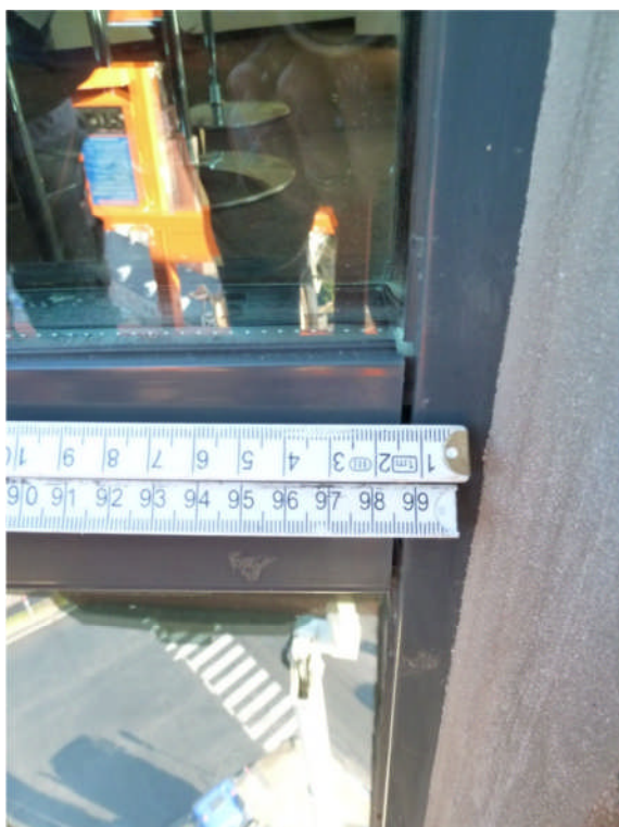
Foto 4.112a en -b: Noordwestgevel – grote openingen (circa 3 mm) in kozijnverbindingen. Raamrubbers zijn te kort (foto 2) – uit de glassponning komt ongedierte.
