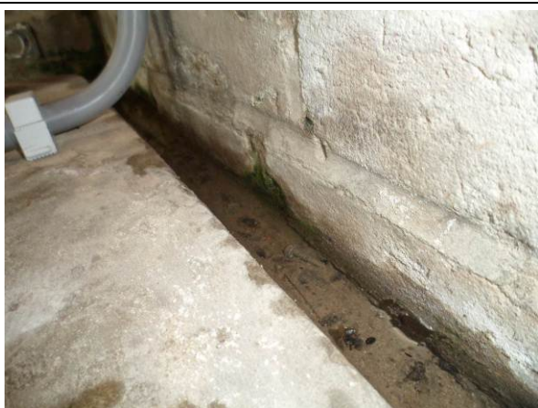
Foto 3.5 en 3.6: Het "gootje" vult zich en water dringt door voegen naar buitenzijde achter de loodslabbe
