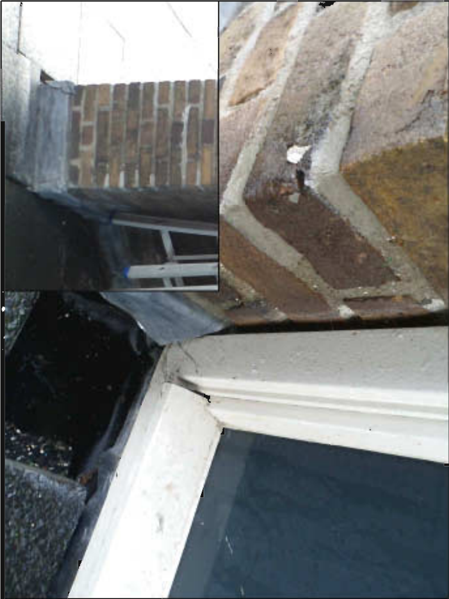
Principe gevelconstructie waar kozijn tegen is geplaatst
