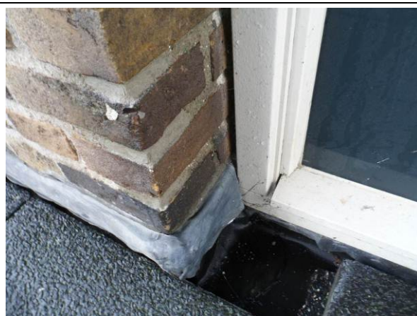
Foto 3.13 en 3.14: Verticale naad tussen massief metselwerk en houten kozijn. Water komt in de platdakconstructie.
