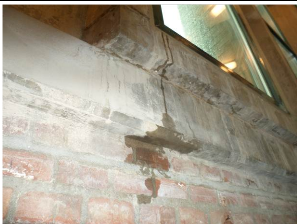
Foto 1.1 en 1.2: Lekkage bij aansluiting betonkader met alu. kozijn en ter plaatse van glaslatten
