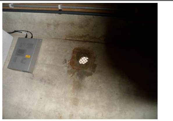
Foto 5.5 en 5.6: Ventilatieopening aan de onderzijde van het dak: Bij harde wind en regen treedt water naar binnen
