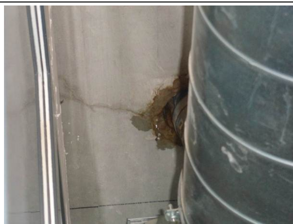
Foto 3.7 en 3.8: Water komt achter de dakbedekking terecht, komt in dakconstructie en treedt uit bij doorvoer
