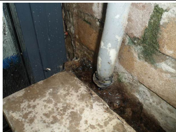
Foto 3.3 en 3.4: Water treedt bij aansluiting gevel-dak naar binnen en stroomt af naar het "gootje"
