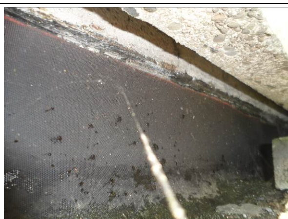
Foto 3.13 en 3.14: Verticale naad tussen massief metselwerk en houten kozijn. Water komt in de platdakconstructie.
