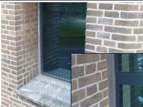
Foto 1.7 en 1.8: Aansluiting gevel met kozijn en leiplaat dorpel
