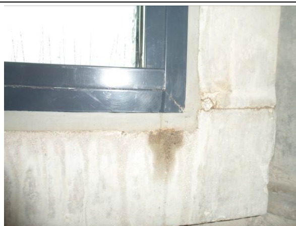
Foto 1.3 en 1.4: Lekkage bij aansluiting betonkader met alu. kozijn en ter plaatse van glaslatten
