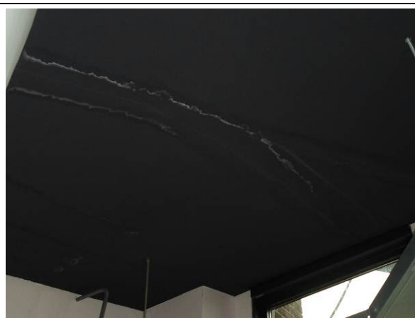
Foto 6.1 en 6.2: Lekstreden op het plafond van de waterkamer (onder de keuken van het restaurant).
