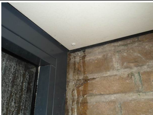
Foto 3.3 en 3.4: Water treedt bij aansluiting gevel-dak naar binnen en stroomt af naar het "gootje"
