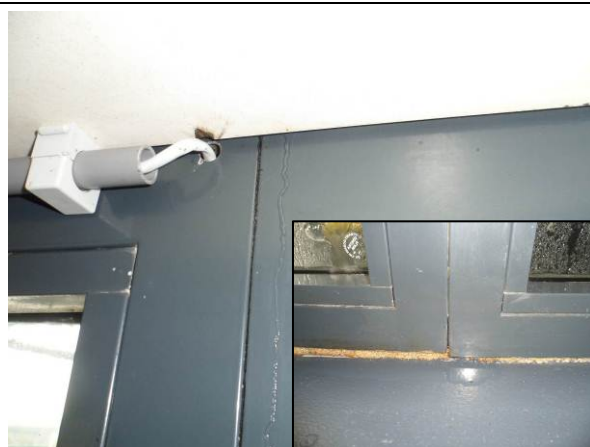
Foto 3.11 en 3.12: naden tussen de beplating bij de bovendorpel, water treedt binnen uit, ook bij de koppelstijlen.
