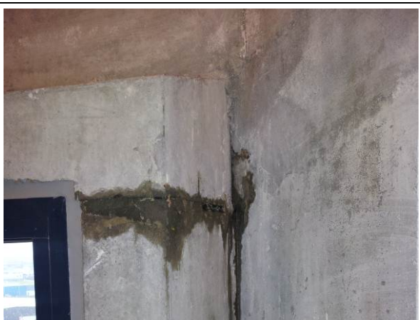
Foto 1.5 en 1.6: Lekkage bij bovendorpel aansluiting van het betonkader en zijstijl
