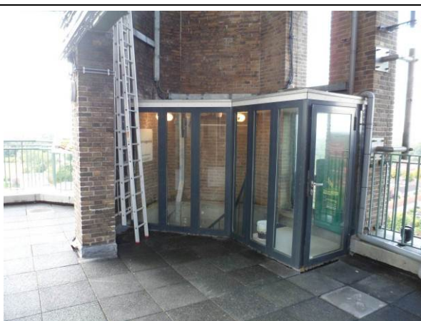
Foto 3.9 en 3.10: Kritische aansluiting bij onderdorpel, water kan achter de dakbedekking terecht komen
