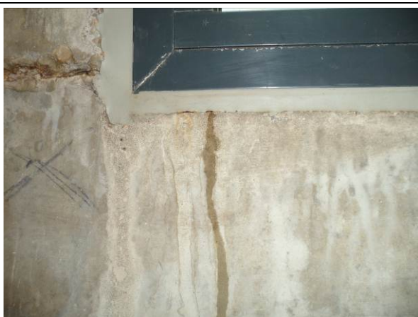
Foto 1.3 en 1.4: Lekkage bij aansluiting betonkader met alu. kozijn en ter plaatse van glaslatten
