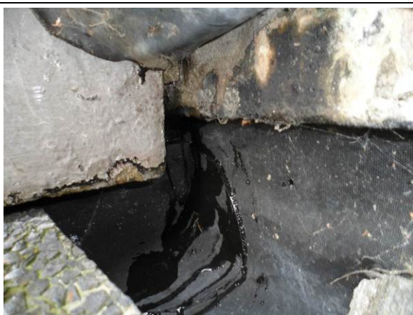
Foto 3.7 en 3.8: Water komt achter de dakbedekking terecht, komt in dakconstructie en treedt uit bij doorvoer
