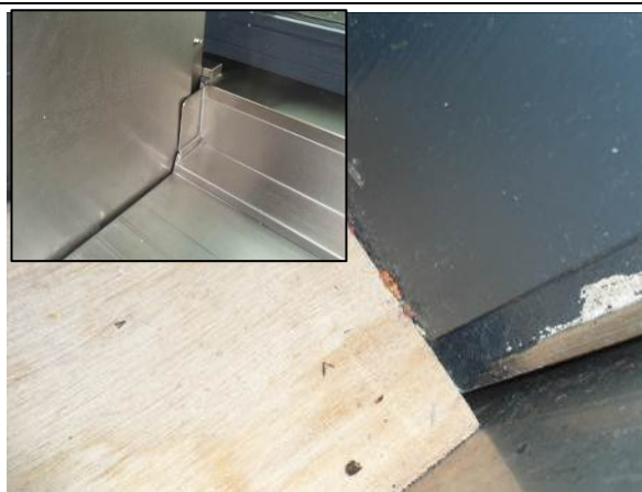
Foto 6.3 en 6.4: Keukenblok restaurant Sonoy. Diverse gebreken die tot lekkages leiden op het plafond (waterkamer).
