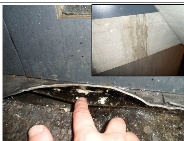
Foto 3.9 en 3.10: Kritische aansluiting bij onderdorpel, water kan achter de dakbedekking terecht komen
