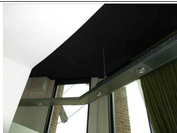
Foto 6.1 en 6.2: Lekstreden op het plafond van de waterkamer (onder de keuken van het restaurant).
