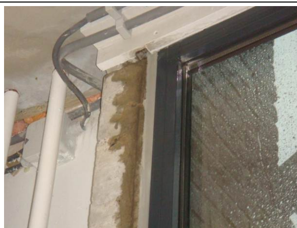
Foto 1.3 en 1.4: Lekkage bij aansluiting betonkader met alu. kozijn en ter plaatse van glaslatten
