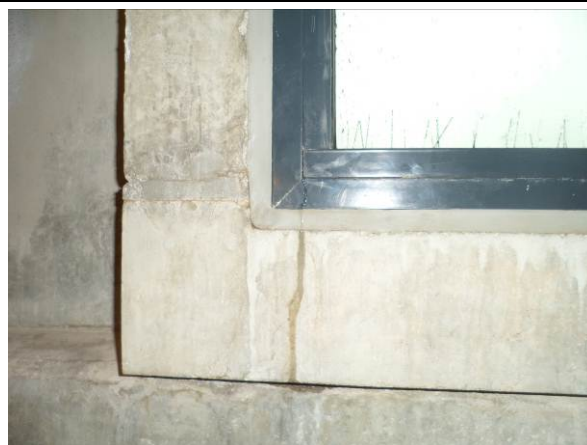
Foto 1.1 en 1.2: Lekkage bij aansluiting betonkader met alu. kozijn en ter plaatse van glaslatten
