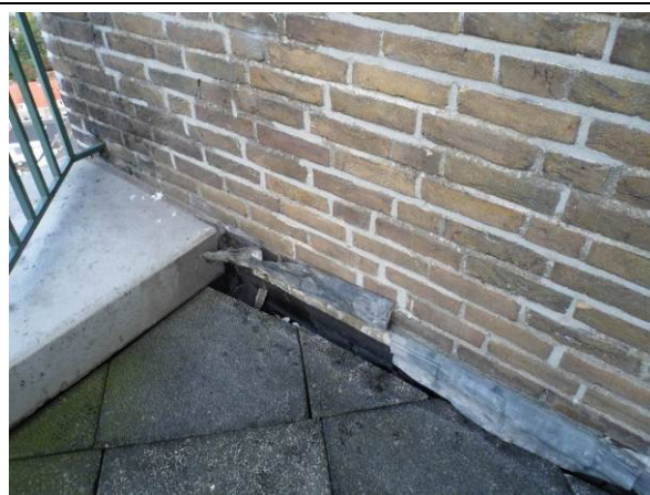
Foto 3.5 en 3.6: Het "gootje" vult zich en water dringt door voegen naar buitenzijde achter de loodslabbe
