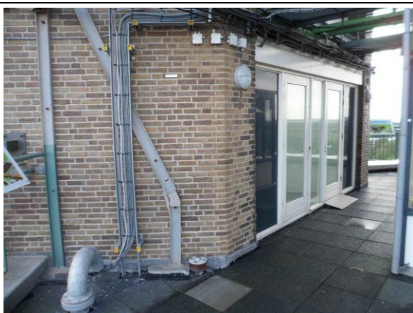
Foto 3.13 en 3.14: Verticale naad tussen massief metselwerk en houten kozijn. Water komt in de platdakconstructie.
