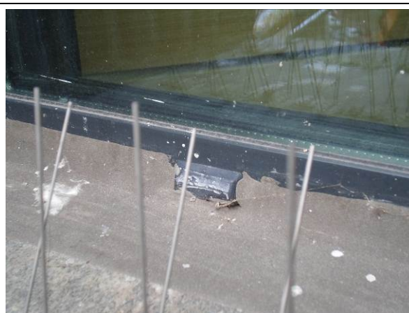
Foto 1.9 en 1.10: Afwateringsopening in het kozijnprofiel zit plaatselijk dicht. Afdichtingsstrook bestaat uit een elastische kitstrook Saba Construseal Plus, geleverd door de firma Zwapex, zie bijlage III
