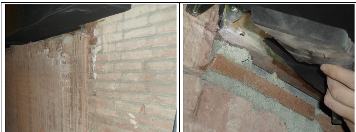
Foto 4.3 en 4.4: Lekstrepen op de muur aan de onderzijde van het rooster
