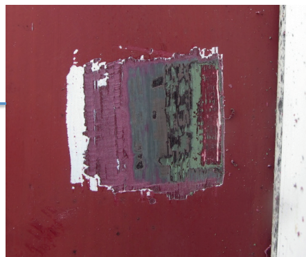
Zuiderwinkels 1. Een kleurentrap op de winkeldeur laat een donkerrode eerste afwerking zien.
