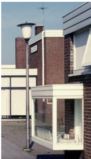
Detail uit een van de historische foto's waarop zichtbaar is dat de regenpijp dezelfde kleur heeft als het boeiboard en de onderzijde zwart is.
