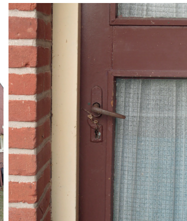
Westgevel Zuiderpoort 1 met de oorspronkelijke deur, hang en sluitwerk en draadglas. Zowel het vaste deel van het kozijn als de deur zelf waren blauw.
