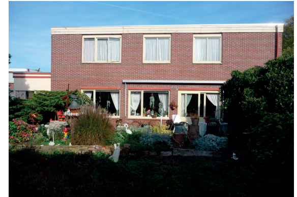
Horizontale stroken en verticale vensterassen bepalen de gevelcompositie.
