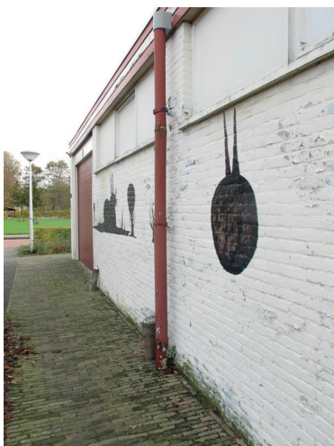
Noordgevel Ring 88. Dit is de enige zinken regenpijp die tijdens het onderzoek werd gevonden. Alle overige plastic exemplaren zijn niet uit de bouwtijd.
