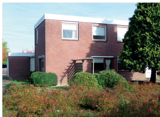
Woningen georiënteerd op het zuiden.
