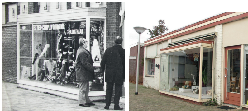
Links detail van een opname uit het fotoalbum van de bewoonster Ring 88 genomen ter gelegenheid van de opening van de winkel in 1972. Rechts de huidige situatie van dit deel van het gebouw; het baksteenwerk is inmiddels van een crèmekleurige laag voorzien.
