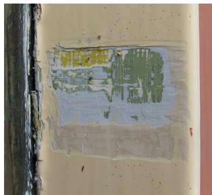
Details van de kleurentrappen op de winkeldeur van Ring 88.
