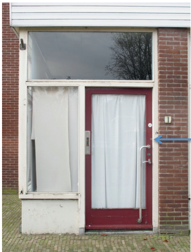
Zuiderwinkels 1. Een kleurentrap op de winkeldeur laat een donkerrode eerste afwerking zien.
