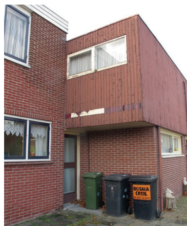
Westgevel Zuiderpoort 1 met de oorspronkelijke deur, hang en sluitwerk en draadglas. Zowel het vaste deel van het kozijn als de deur zelf waren blauw.
