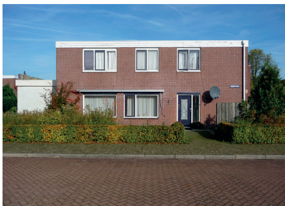
Woningen georiënteerd op het zuiden.
