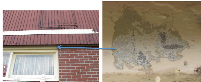
Sondering op de latei boven een van de vensters van Zuiderpoort 1
