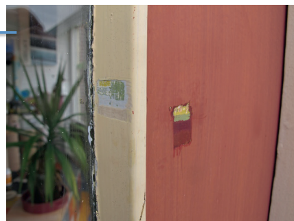
Ring 88. Een kleurentrap laat als eerste afwerking een felgele kleur op een witte grondering zien.
