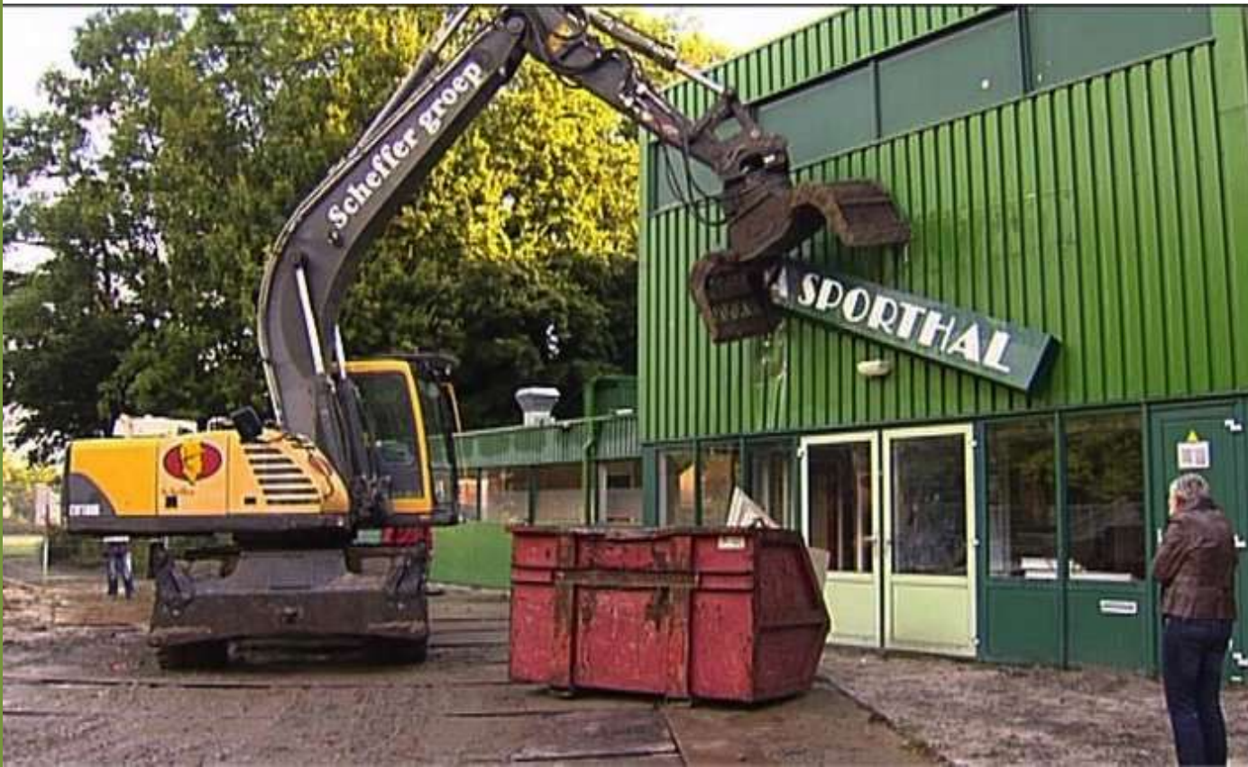
In 2013 wordt de Prins Willem Alexander sporthal aan de Scandinaviëlaan in Emmeloord afgebroken.
