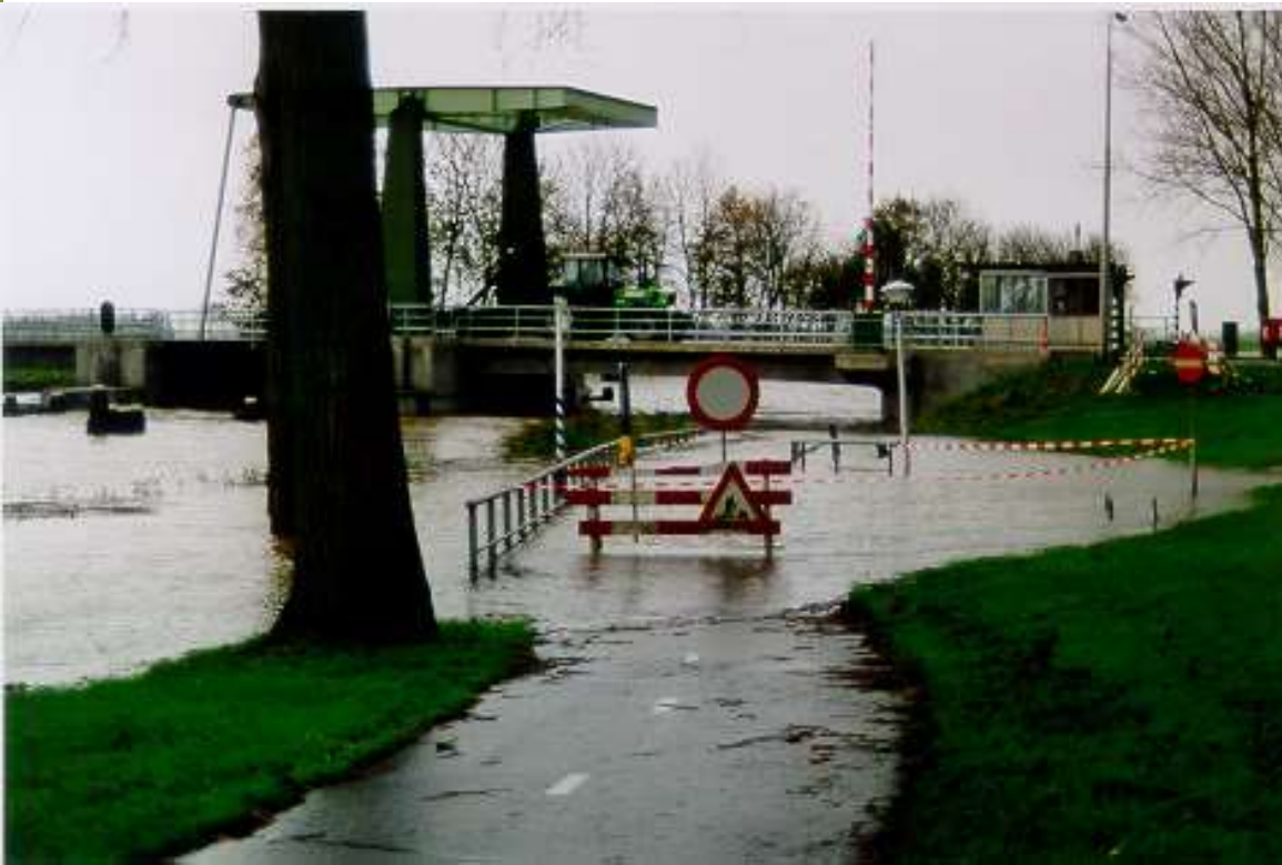
Brug over de Urkervaart bij Tollebeek
