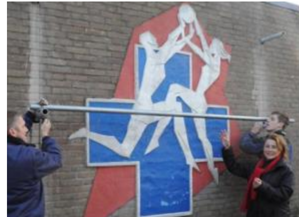
Afb. 39 2011: Reliëf wordt gedemonteerd door sloopbedrijf (foto Stentor4-12-2010)
