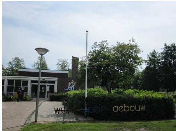
Afb. 35 Bestaan de letters WIJKSPORTGEBOUW nog? (foto: Peter Timmer)
