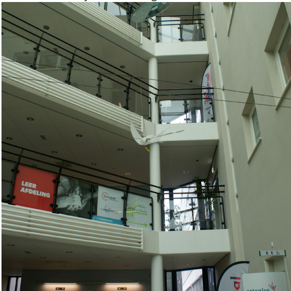
Afb. 33 Het hoofdvolume rechts is met een nieuw tussenlid met de latere uitbreiding links verbonden.
