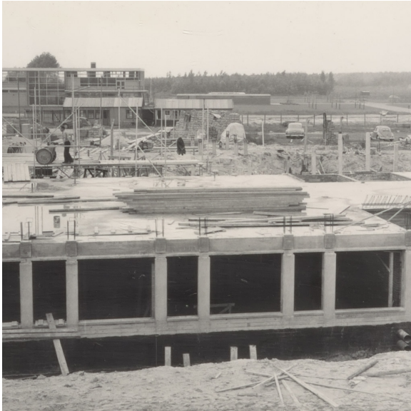
Afb. 24 Deze foto van het ziekenhuis tijdens de bouw biedt zicht op het betonskelet
