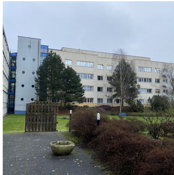
Afb. 28 Het aanzicht van de nieuwe ziekenhuisvleugel op de plek van de eerdere zusterflat.
