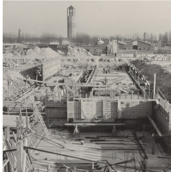
Afb. 25 De bouwplaats met op de achtergrond de kerk-torens van Emmeloord als bakens.
