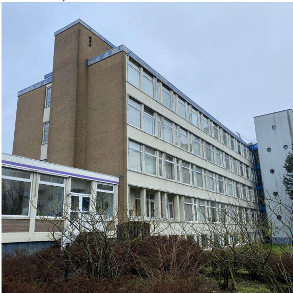
Afb. 27 Het nieuwe atrium met trappenhuis (rechts) in de oksel van de bestaande vleugel en de nieuwbouw.
