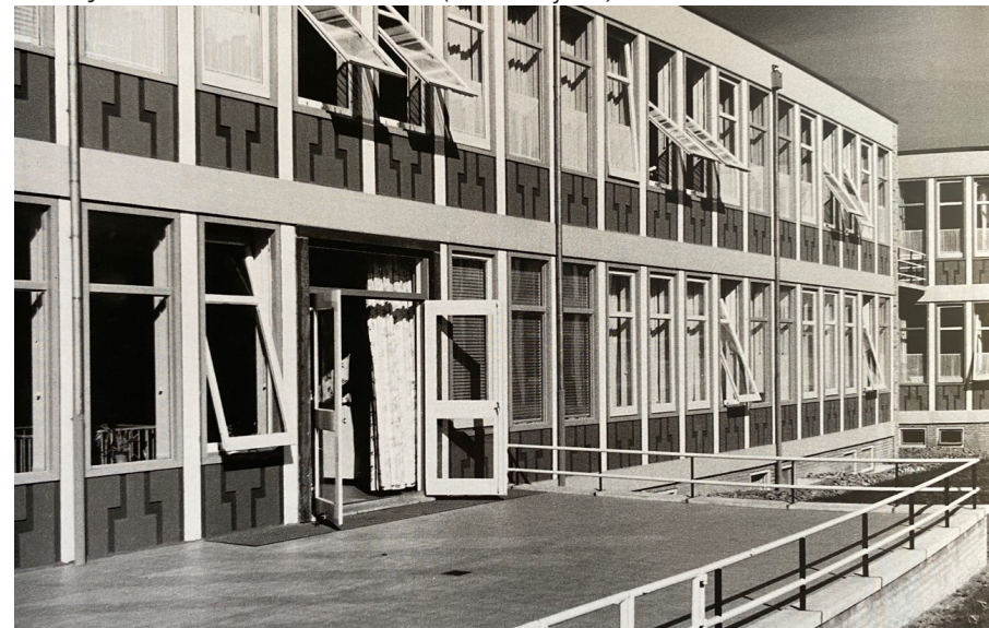
Afb. 17 Detail van de gevel van int Gregorius Ziekenhuis in Brunssum met de prefab gevelelementen (Mens & Tijhuis).
