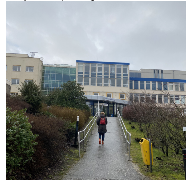
Afb. 29 De volumewerking is door nieuwbouw en de opgehoogde aangrenzende vleugel verstoord.
