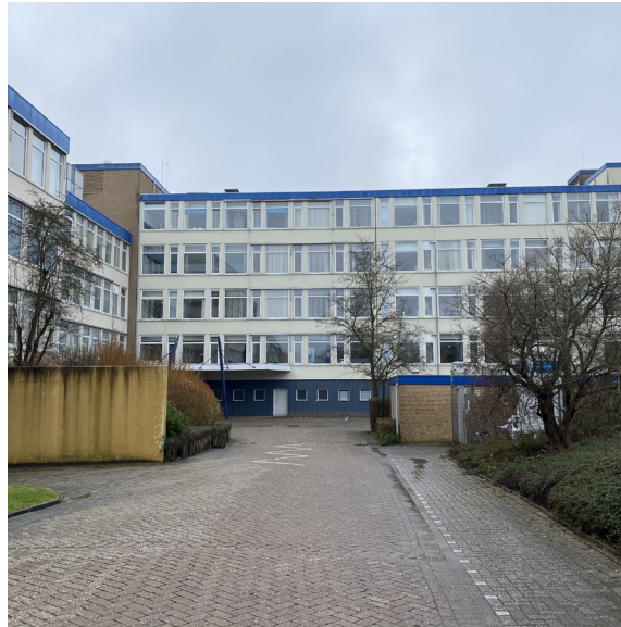
Afb. 31 Aanzicht van de westelijke vleugel rechts voor verdiepte garages.
